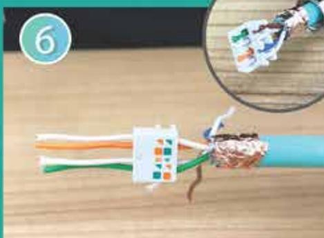
6 然後根據理線器上的顏色指引把相應顏色的線插入理線器中。留意要在外皮與理線器中間預留5-8mm的距離，再用剪鉗剪去外露的線尾。
