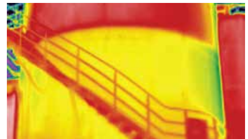
Oil Tank Inspection 對儲罐液位綫進行快速校驗
